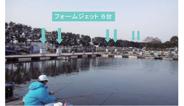
アオコ発生抑制、酸欠対策 (フォームジェット+濃縮酸素)
